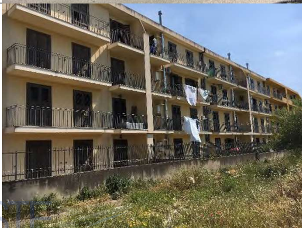
Foto 2 Prospetto secondario (lato Nord Ovest)
